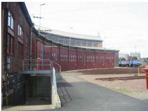
Det norra lokstallet.
