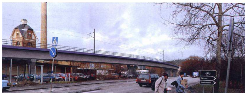
Fotomontage över ny bro för Triangelspåret. I bakgrunden skimtar Slakthusområdets karakteristiska byggnader. Fotomontage: Banverket
