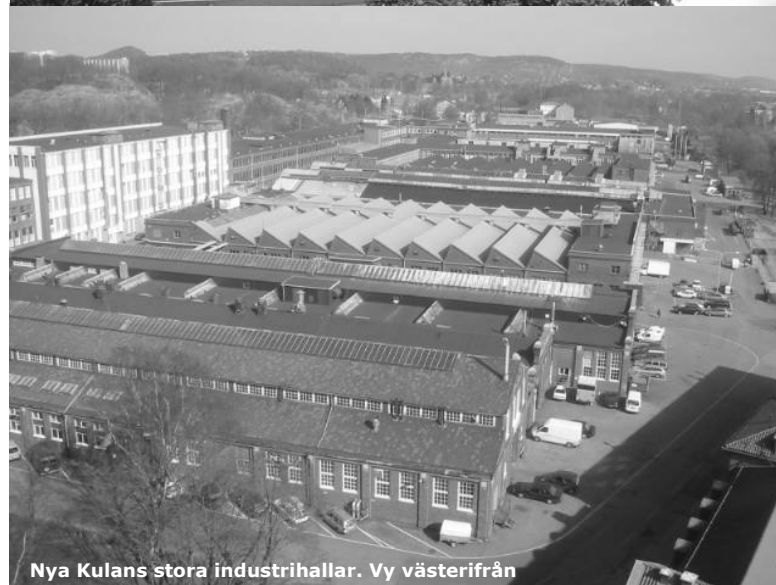
AJCO stora tegelbyggnad utmed Artillerigatan.
