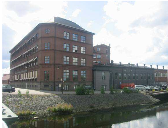
Gamlestads fabriker sett från norra sidan av Sävån.
