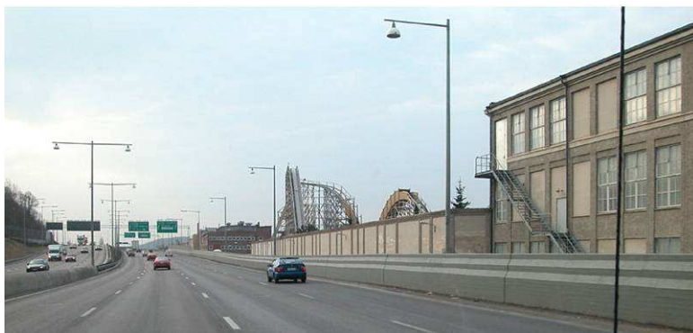
Mur för skärmning av värmestrålning vid Liseberg. Fönster på byggnaden intill har i viss omfattning murats igen. Utmed trafikleden kant finns avkörningsskydd som är dimensionerat att stå emot tungt fordon, så att detta inte faller ned på intilliggande gata nedanför leden.
